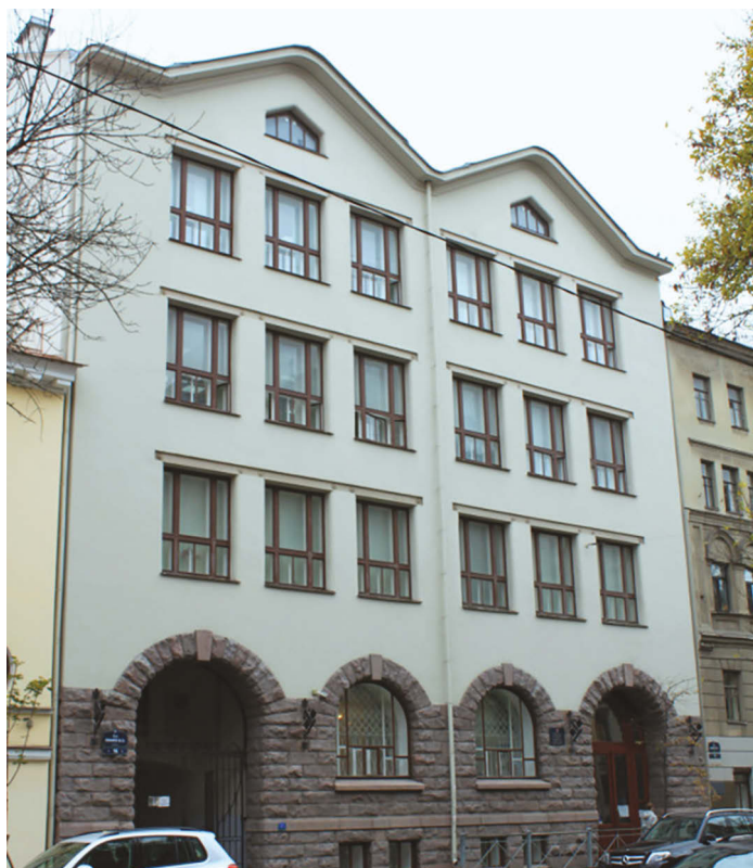
Здание гимназии Э. П. Шаффе на 5-й линии В. О., 16
